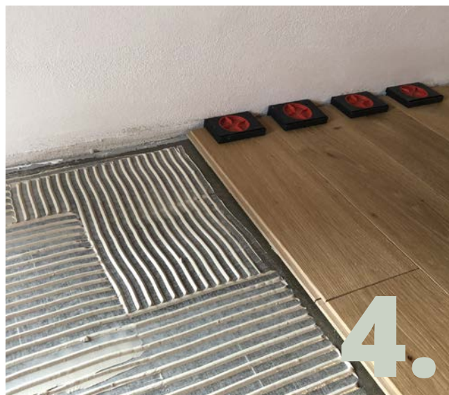
Celoplošné lepení lepidlem na masivní dřevěné podlahy a dilatační klínky 10 mm od zdi
