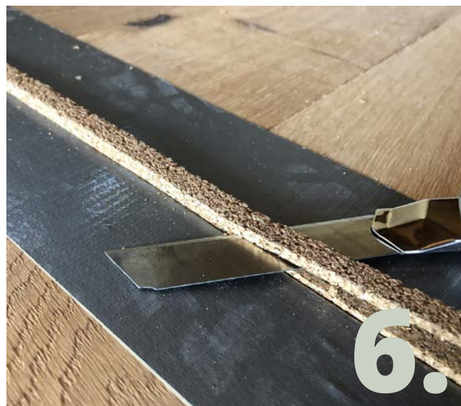
Příprava korkové dilatace místo přechodových lišt
