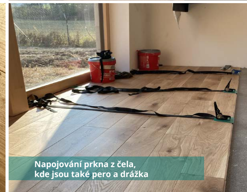
Celoplošné lepení, lepidlem na masivní podlahy a parkety
