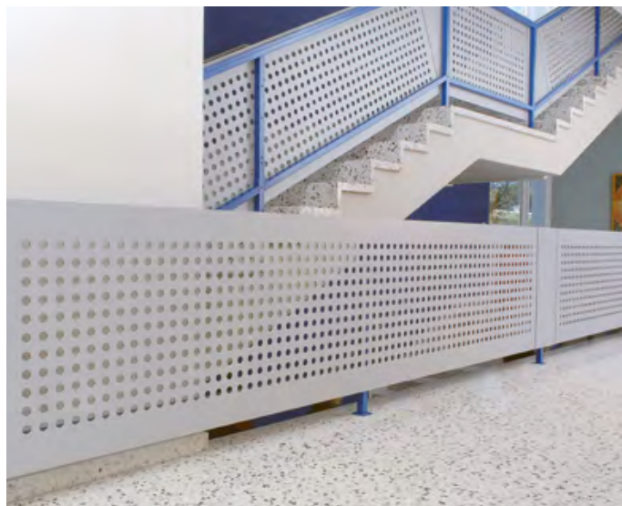
PŘÍKLAD SCHODIŠŤOVÉ VÝPLNĚ ZÁBRADLÍ
